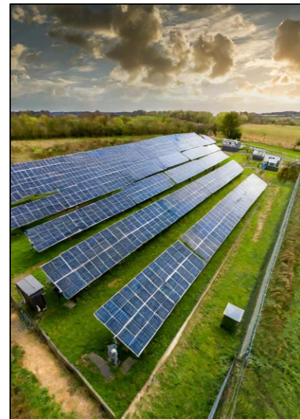
Quelle: Adobe Firefly. Freiflächen-PV Anlage.
