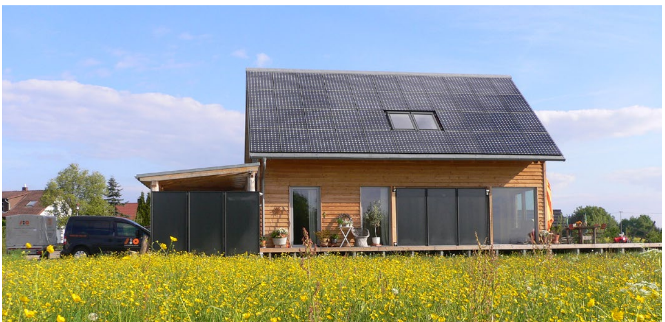
Vollbelegtes PV-Dach in Abtsgmünd/Ostalbkreis Baden-Württemberg. Quelle: Thomas Seltmann
