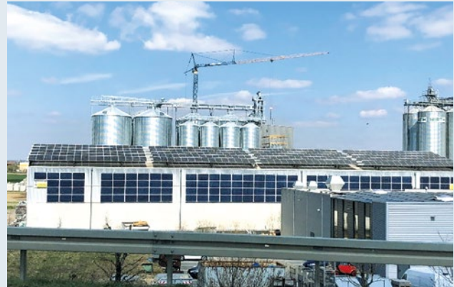
Agrarhandel Wirth in Illertissen. Dach- und Fassaden- Photovoltaik.
