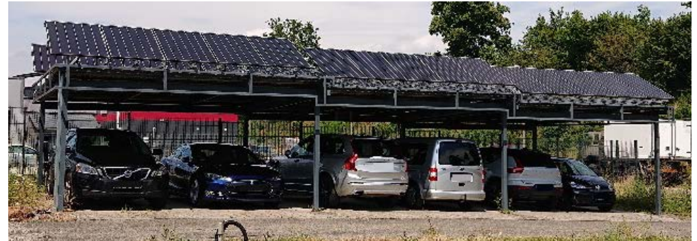
Mit aufgeständerten PV-Modulen überdachte PKW-Stellplätze. Quelle: © Art 28 GmbH & Co. KG
